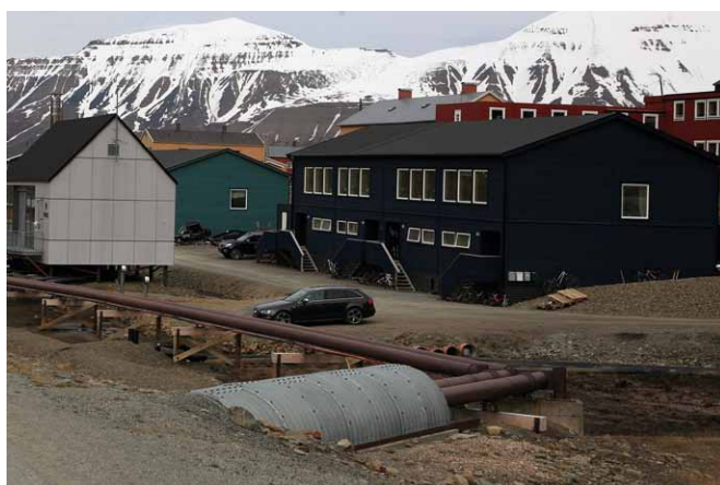
Wykonanie instalacji kablowej w strefie wiecznej zmarzliny
