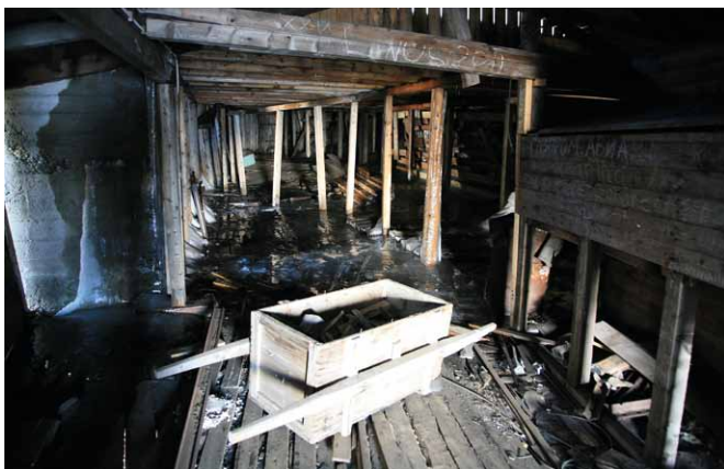
Obudowa wyrobiska kopalni Gruve 2b
