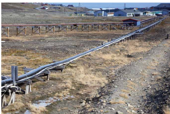
Linie kablowe prowadzone w rurach ochronnych
