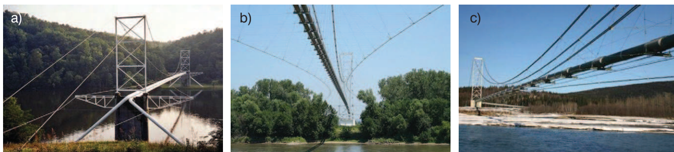
Rys. 2. a) most w Clayton nad rzeką Coosa, Alabama, USA (fot. Patrick S. O'Donnell) {1}, b) most w Plattsmouth nad rzeką Missouri, Nebraska, USA (fot. Patrick S. O'Donnell) {1}, c) most w pobliżu Fairbanks nad rzeką Tanana, Alaska, USA (fot. Patrick S. O'Donnell) {2}
