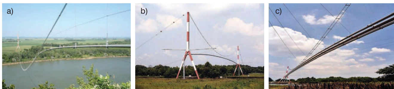
Rys. 4. a) most w Ponca nad rzeką Missouri, Nebraska, USA (fot. Patrick S. O'Donnell) {1}, b) most nad kanałem Wax Lake Outlet, Louisiana, USA (fot. Patrick S. O'Donnell) {1}, c) most nad kanałem Wax Lake Outlet, Louisiana, USA (fot. Patrick S. O'Donnell) {1}
