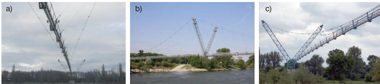
Rys. 8. a) most w pobliżu Wiednia nad rzeką Dunaj Austria (fot. Karl Gruber) {5}, b) most w pobliżu Wiednia nad rzeką Dunaj Austria (fot. Karl Gruber) {5}, c) most we Wrocławiu nad Odrą, Polska (fot. z archiwum autora)
