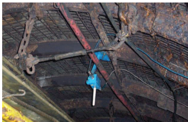
Rys. 2. Głowica lokalizacyjna typu LHU
