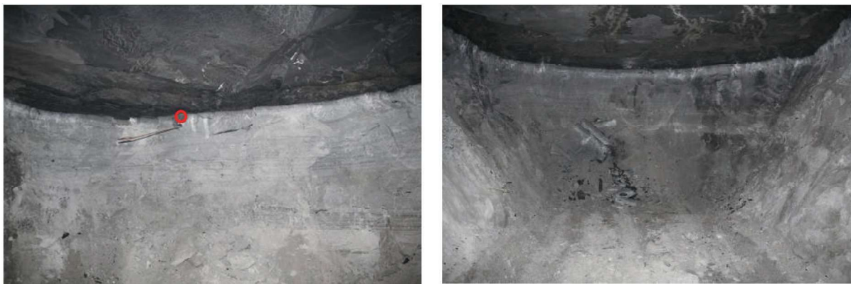
Rys. 6. Efekty strzelania porównawczego: a - Emulex 100AL, b - Ergodyn 22E, czerwonym kółkiem zaznaczono pozostałą w caliznie resztkę otworu strzałowego („fajkę”)
