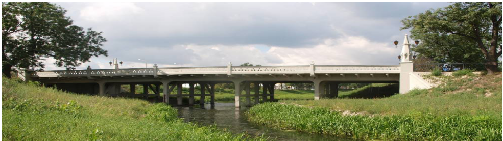
Rys. 20. Most w ciągu ulicy Zamojskiej – stan obecny.
