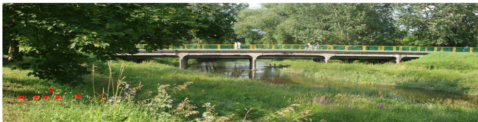
Rys. 1. Widok na most na Kalinowszczyźnie od napływu, stan z 2013 r.
