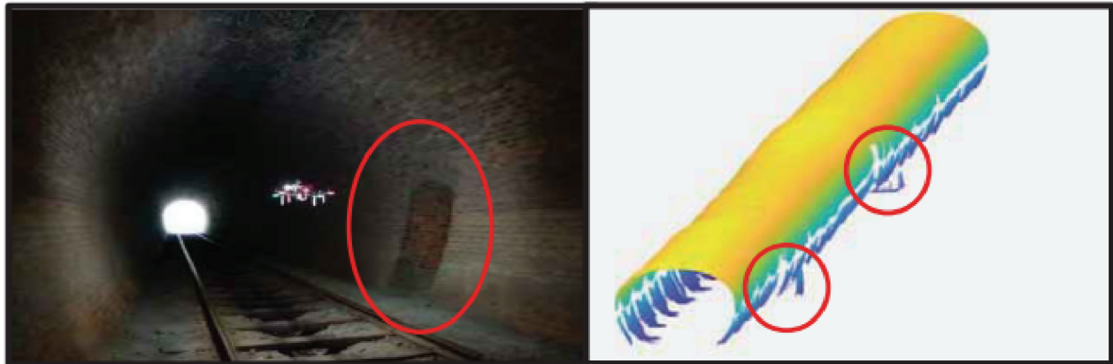
Rys. 3. Inspekcja tunelu: a) dron podczas kontroli [29], b) chmura punktów 3D tunelu z wnękami [39]
