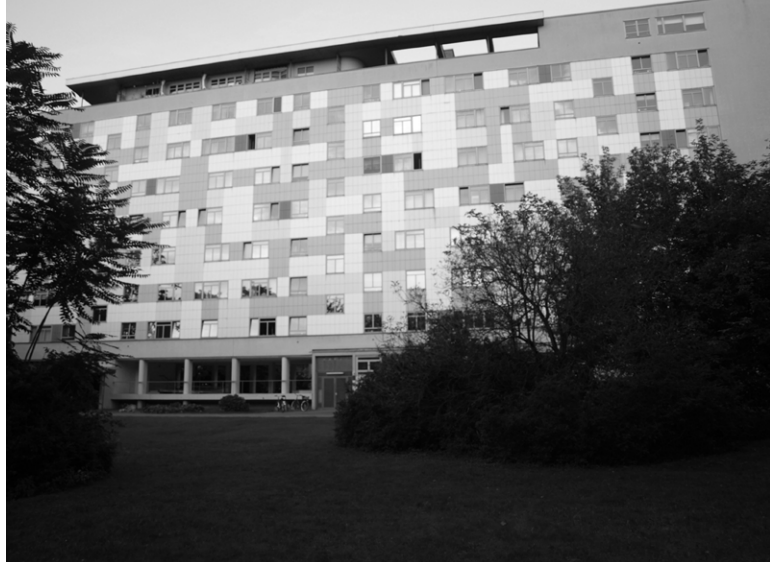
Ryc. 9. Budynek Pierre'a Vago – elewacja zachodnia. Fot. W. Niebrzydowski
