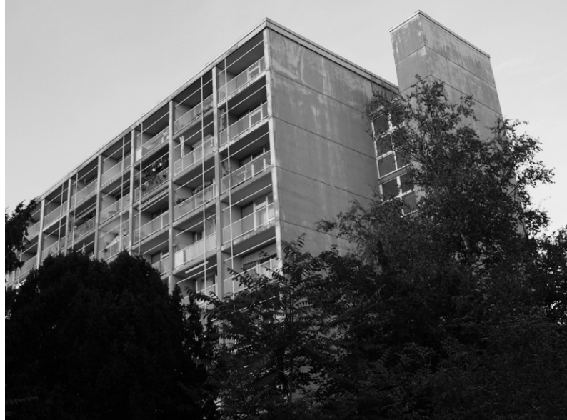
Ryc. 6. Budynek Egon Eiermanna – narożnik południowo-zachodni. Fot. W. Niebrzydowski
