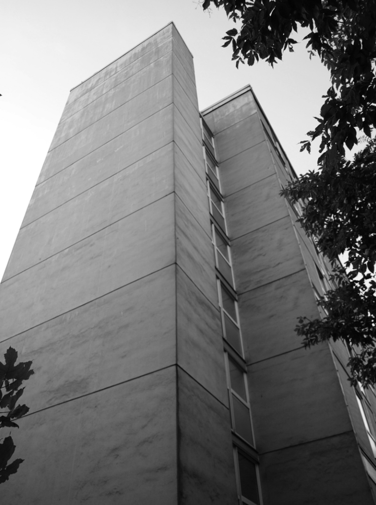
Ryc. 4. Budynek Egon Eiermanna – szyb windy i klatka schodowa w bocznej elewacji. Fot. W. Niebrzydowski
