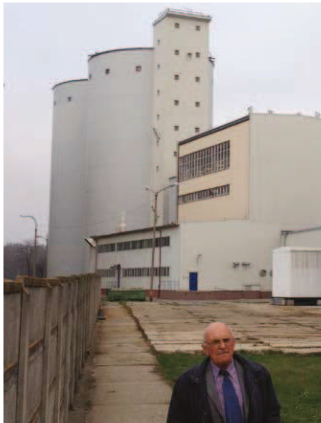
Rys. 1. Silosy strunobetonowe do przechowywania cukru – po przeprowadzeniu prac naprawczych
