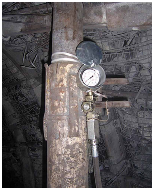
Fot. 5. Stanowisko do pomiaru obciążenia w wyrobisku
