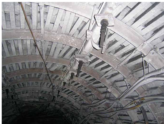
Fot. 1. Widok podciągu przykotwionego kotwami strunowymi
