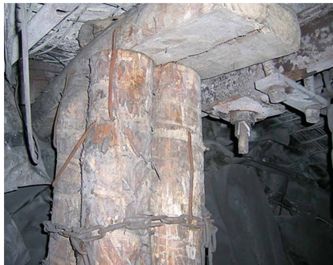
Fot. 2. Widok podciągu przykotwionego kotwami strunowymi
