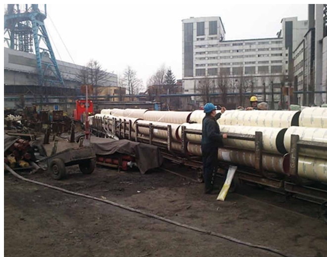
Fot. 3. Widok kartonowych tub szalunkowych w trakcie transportu
