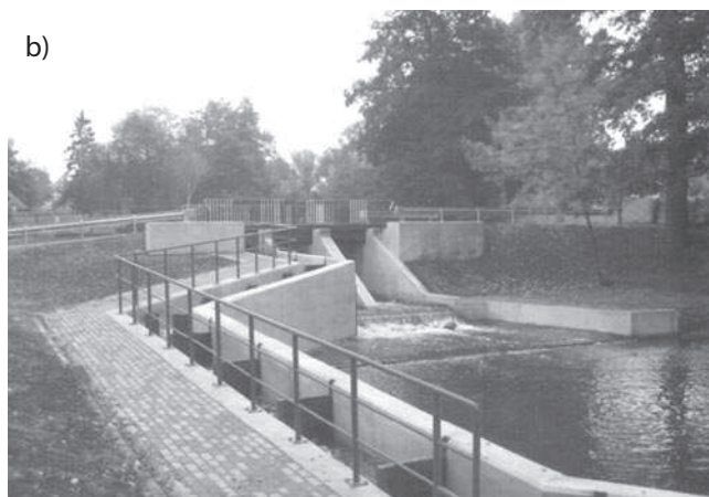
Rys. 2. Jaz stopnia wodnego Krajenka (widok od górnej wody): a) przed modernizacją, b) po modernizacji
