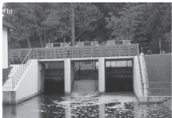
Rys. 4. Jaz stopnia wodnego Strużyska (widok od dolnej wody): a) przed modernizacją, b) po modernizacji
