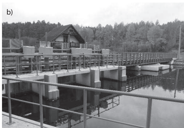
Rys. 5. Jaz stopnia wodnego Strużyska (widok od górnej wody): a) przed modernizacją, b) po modernizacji
