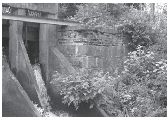
Rys. 3. Jaz stopnia wodnego Krajenka: a) przed modernizacją, b) po modernizacji
