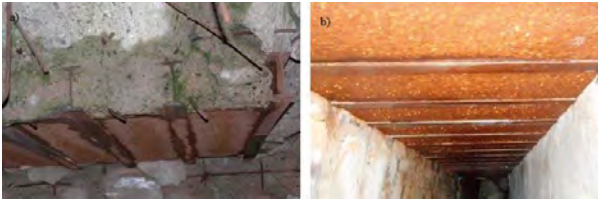
Rys. 1. Przekrój przez strop na belkach stalowych (a), widok zachowanego w dobrej kondycji stropu (b)
