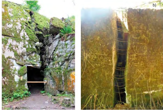
Rys. 7. Widoczna rola zbrojenia w zapewnieniu ciągłości i zwartości konstrukcji żelbetowych (fotografie własne)
