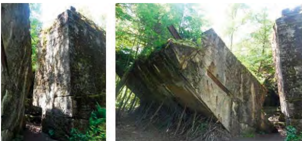
Rys. 6. Bloki betonowe ścian ciężkich bunkrów betonowych (fotografie własne)
