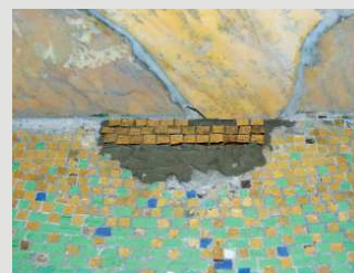
Fot. 9. Fragment szklanej mozaiki w trakcie rekonstrukcji brakujących kostek
