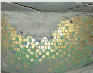
Fot. 8. Fragment mozaiki na dnie niecki przed konserwacją i restauracją
