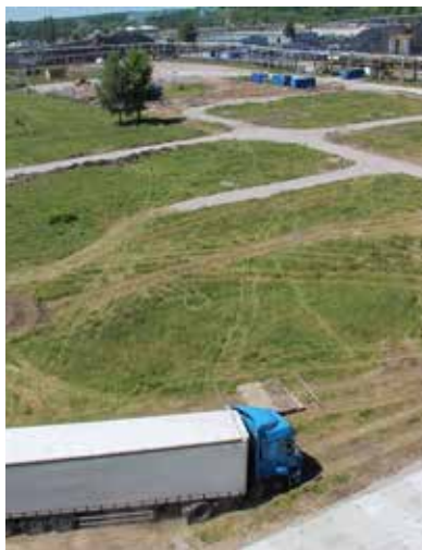
Przygotowanie placu budowy i rozpoczęcie budowy (lipiec 2015 r.)
