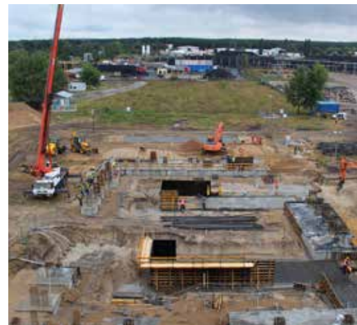
Okres budowy: Zbrojenie stóp fundamentowych w budynku głównym (wrzesień 2015 r.)
