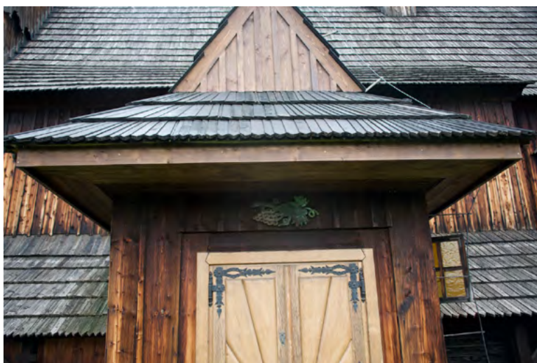
Ryc. 5. Wejście od strony południowej, widoczne elementy podhalańskie, fot. M. Petri
