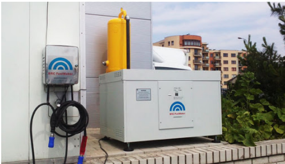
Rys. 5. Kompresor CNG - sprężarka gazu ziemnego Źródło: www.kompresorcng.pl .
