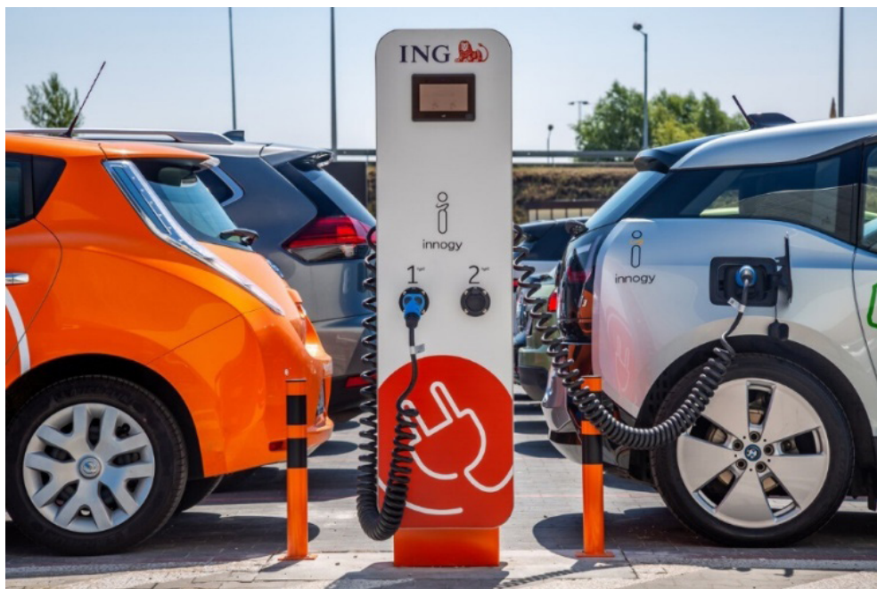
Rys. 2. Przykładowy punkt ładowania samochodów elektrycznych Źródło: www.media.ing.pl/informacje-prasowe/1636/pr/396579/ing-lease-sfinansowal-stacje-ladowania-samochodow-elektrycznych .
