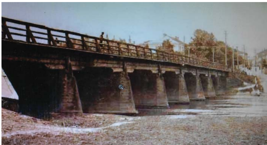
Rys. 3b. Widok na podpory mostu [1]
