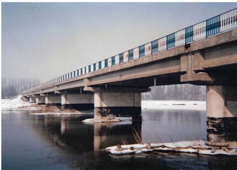
Rys. 12. Nowy most na Wieprzu w Bobrownikach – stan rok 1989 (archiwum własne autora)
