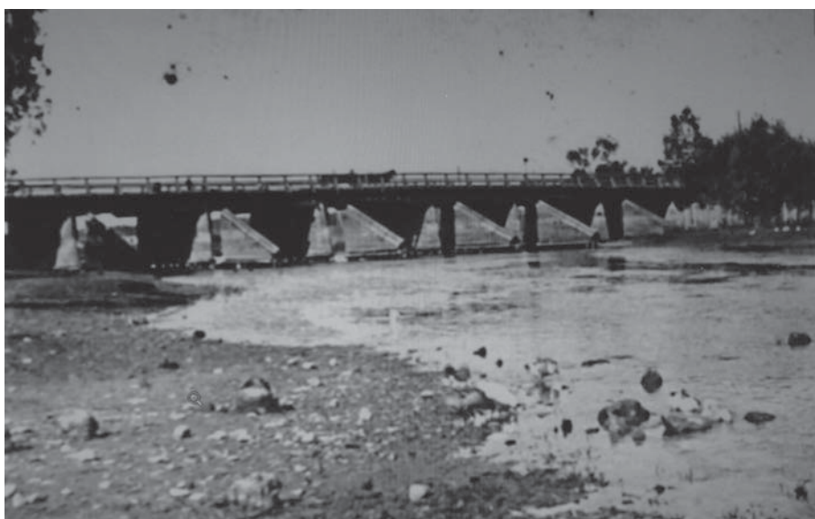
Rys. 4. Most na Wieprzu w Krasnymstawie (rok 1931–1935) [1]
