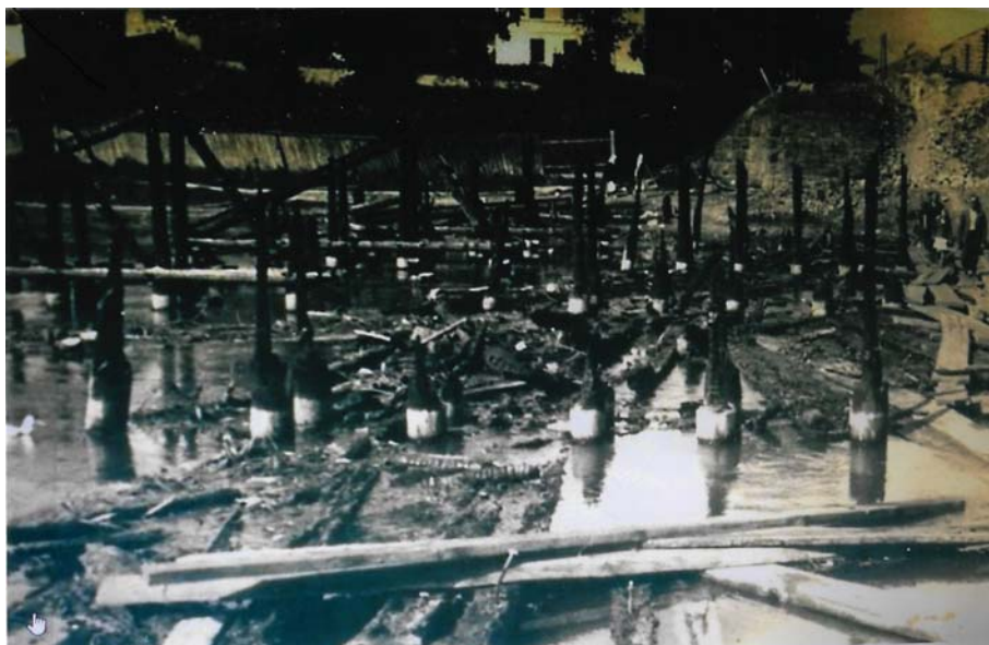
Rys. 5. Fragmenty zniszczonego mostu na Wieprzu (rok 1939) [1]
