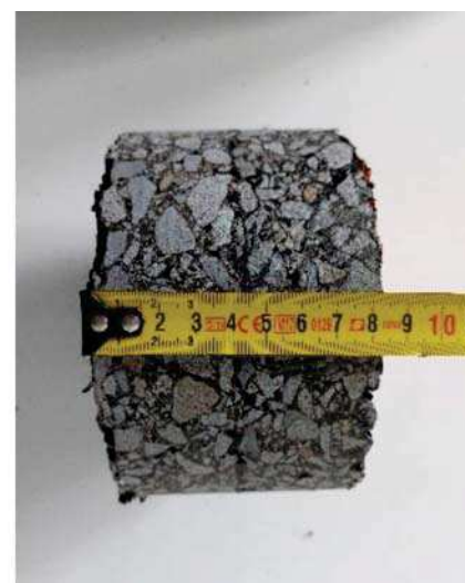
Fot. 5. Rdzeń pozyskany z próbki płytowej o układzie „4+4” z siatką nr 1 (K. Żołnowski)
