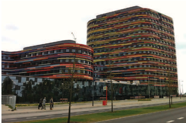
Rys. 3. Prawa część bramy dzielnicy – Centrum administracji – budynek BSU
