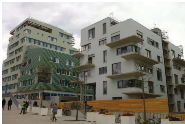
Rys. 5. Lewa strona bramy dzielnicy – Centrum usług medycznych, Budynek lekarza, Akademia Wyspy, 5¼ budynek drewniany
