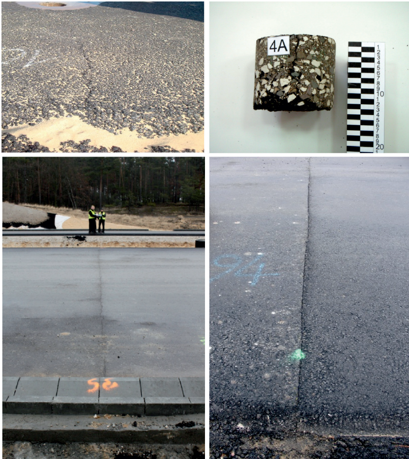
Fot. 1. Zdjęcia spękań niskotemperaturowych podbudowy z betonu asfaltowego o wysokim module sztywności AC WMS na autostradzie w budowie, według [7]
