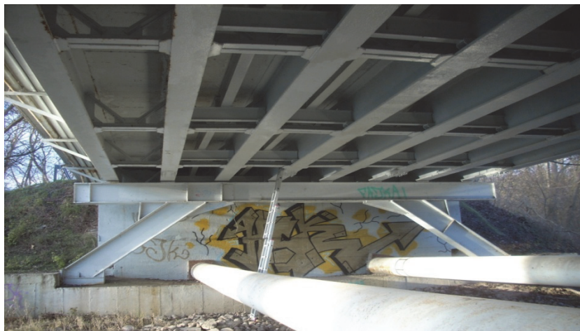
Rys. 4. Widok spodu przęsła
