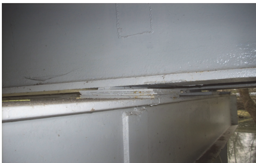
Rys. 7. Widok podparcia pośredniego z podkładkami
