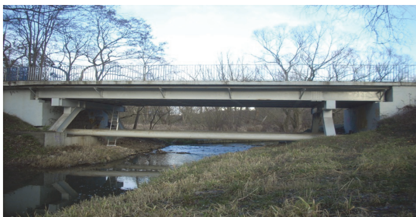
Rys. 5. Most w widoku od strony dolnej wody
