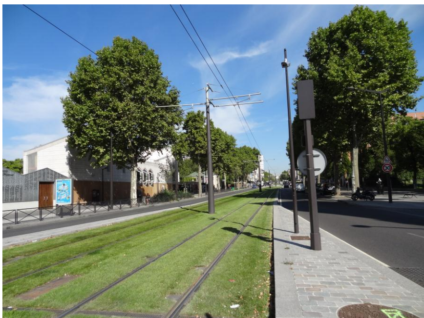
Rys. 1. System zielonych połączeń. Zielone torowisko dla tramwajów, Paryż [fot. M. Trojanowska]
