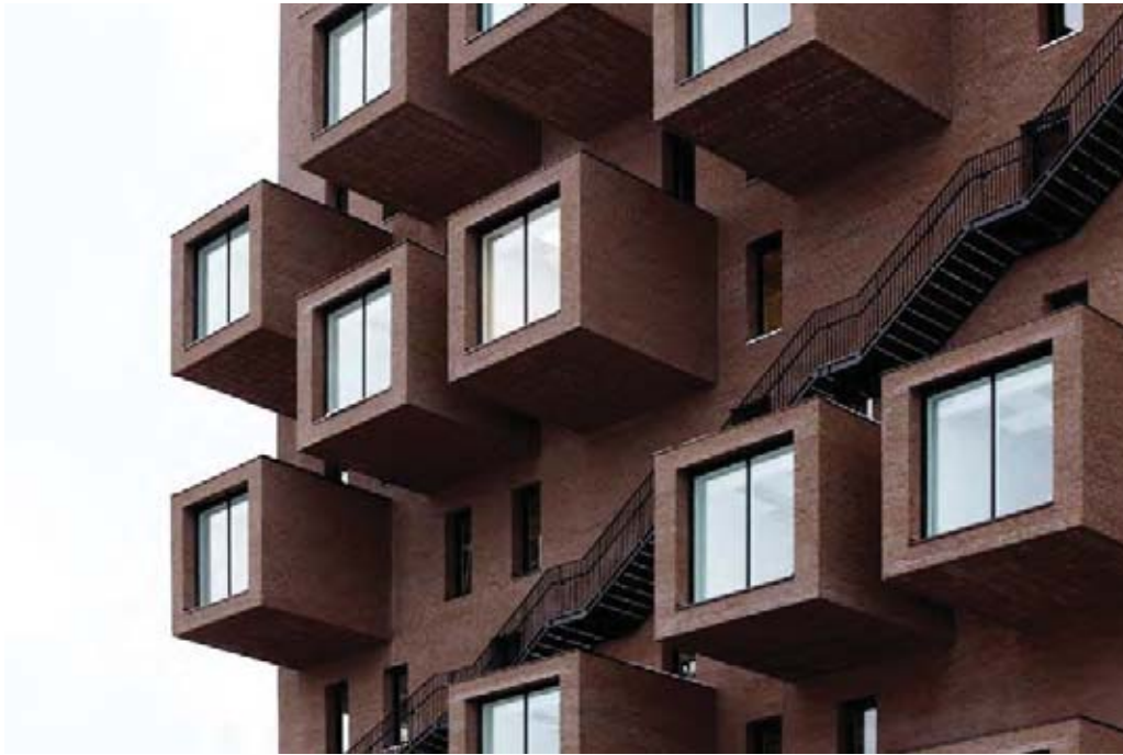
III. 21. Budynek The Wedge cechuje charakterystyczny układ wystających poza lico budynku wykuszy - sal konferencyjnych oraz zewnętrznej klatce ewakuacyjnej (źródło: a-lab.no [dostęp 18.06.2018])
