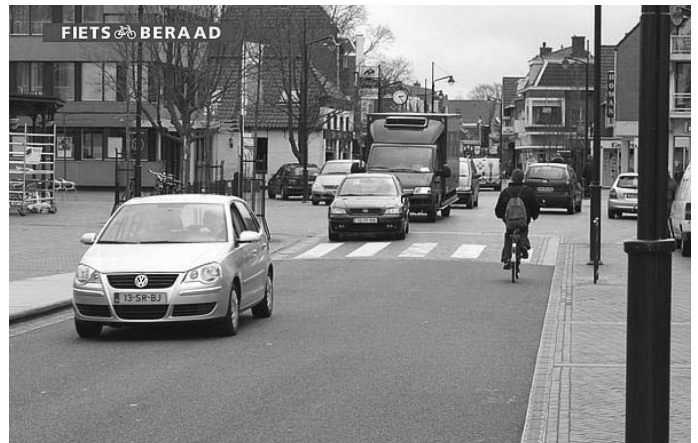
Fot. 2. Przykład rozróżnienia funkcji za pomocą rodzaju nawierzchni Źródło: www.fietsberaad.nl
