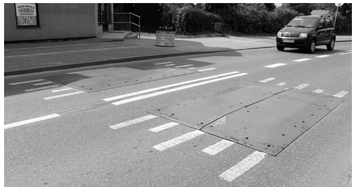
Fot. 3. Przykład zastosowania progów wyspowych (fot. A. Książek)
