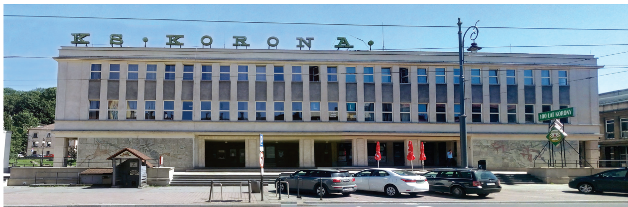
Il. 7. Budynek frontowy KS Korona (fot. A. Rykaczewska, 2020)
