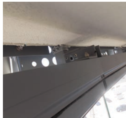
Rys. 7. Rozwiązanie połączenia górnej prowadnicy ze słupkiem balustrady
