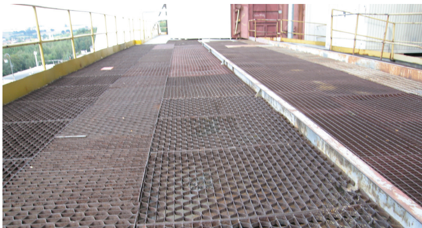
Fot. 3. Specjalny podest roboczy z krętek pomostowych nad papowym pokryciem dachu budynku kotłowni
