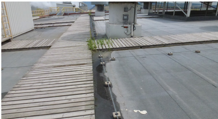
Fot. 2. Pokrycie papowe na wełnie mineralnej z podestami roboczymi na dachu budynku kotłowni
