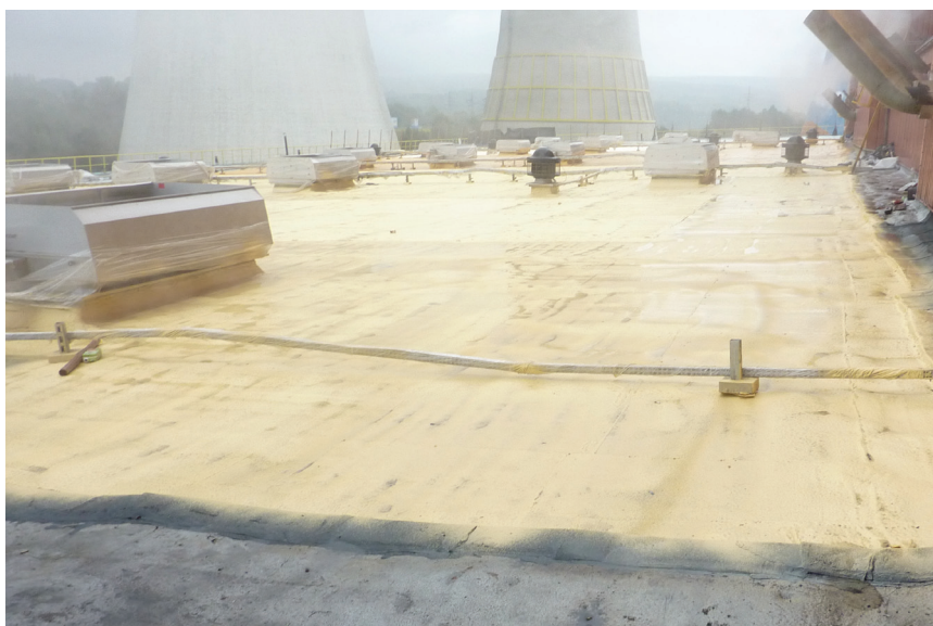
Fot. 9. Końcowy etap nakładania pianki PUR na części dachu budynku maszynowni
