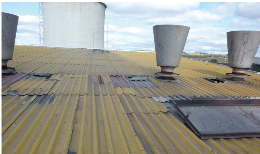
Fot. 10. Pokrycie z blachy faldowej dachu nieczynnego budynku kotłowni
