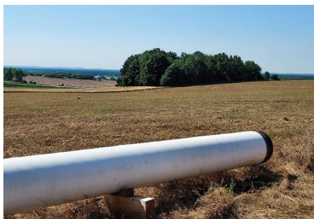
Rys. 2. Budowa infrastruktury przesyłowej na terenach wiejskich
