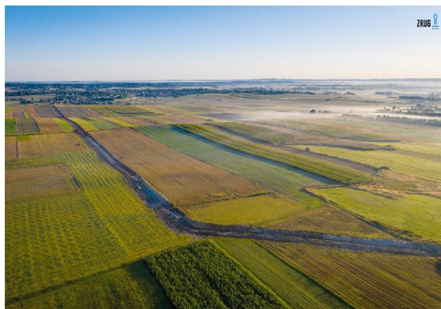
Rys. 1. Ogólny widok pasa montażowego inwestycji liniowej
