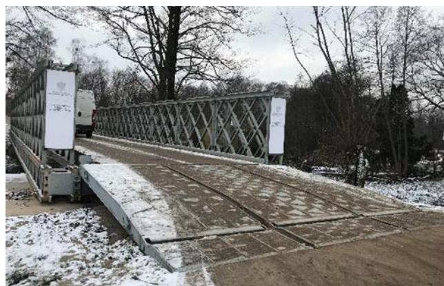
Rys. 5. Most tymczasowy z konstrukcją DMS-65 w Szeligach
