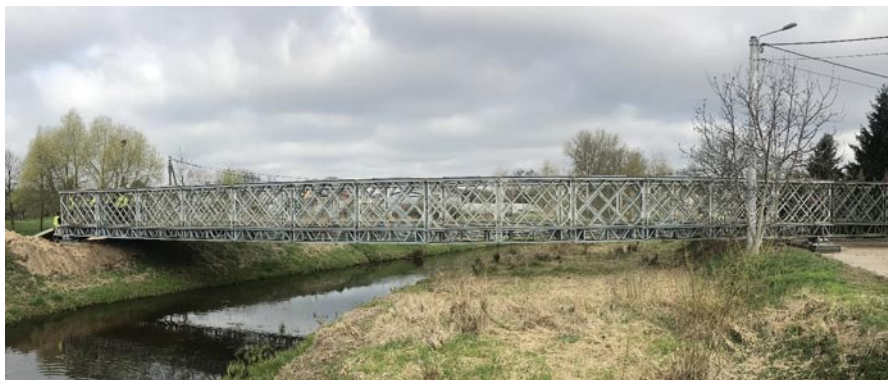
Rys. 3. Most objazdowy z konstrukcji DMS-65 w Kaliszu
