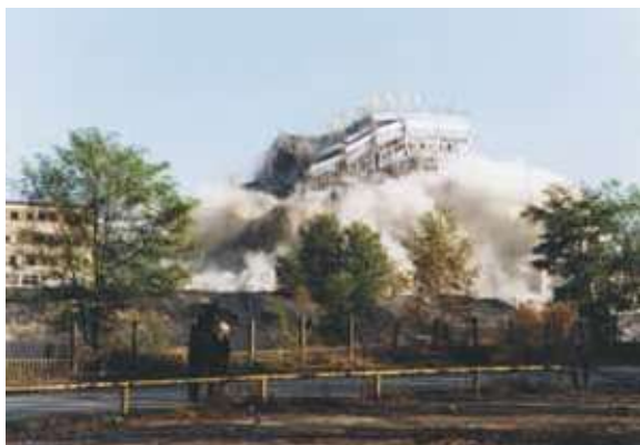
Rys. 3. Wysadzanie budynku Zakładu Przeróbki Mechanicznej KWK „Siersza” (Fot. A. Kabala)
