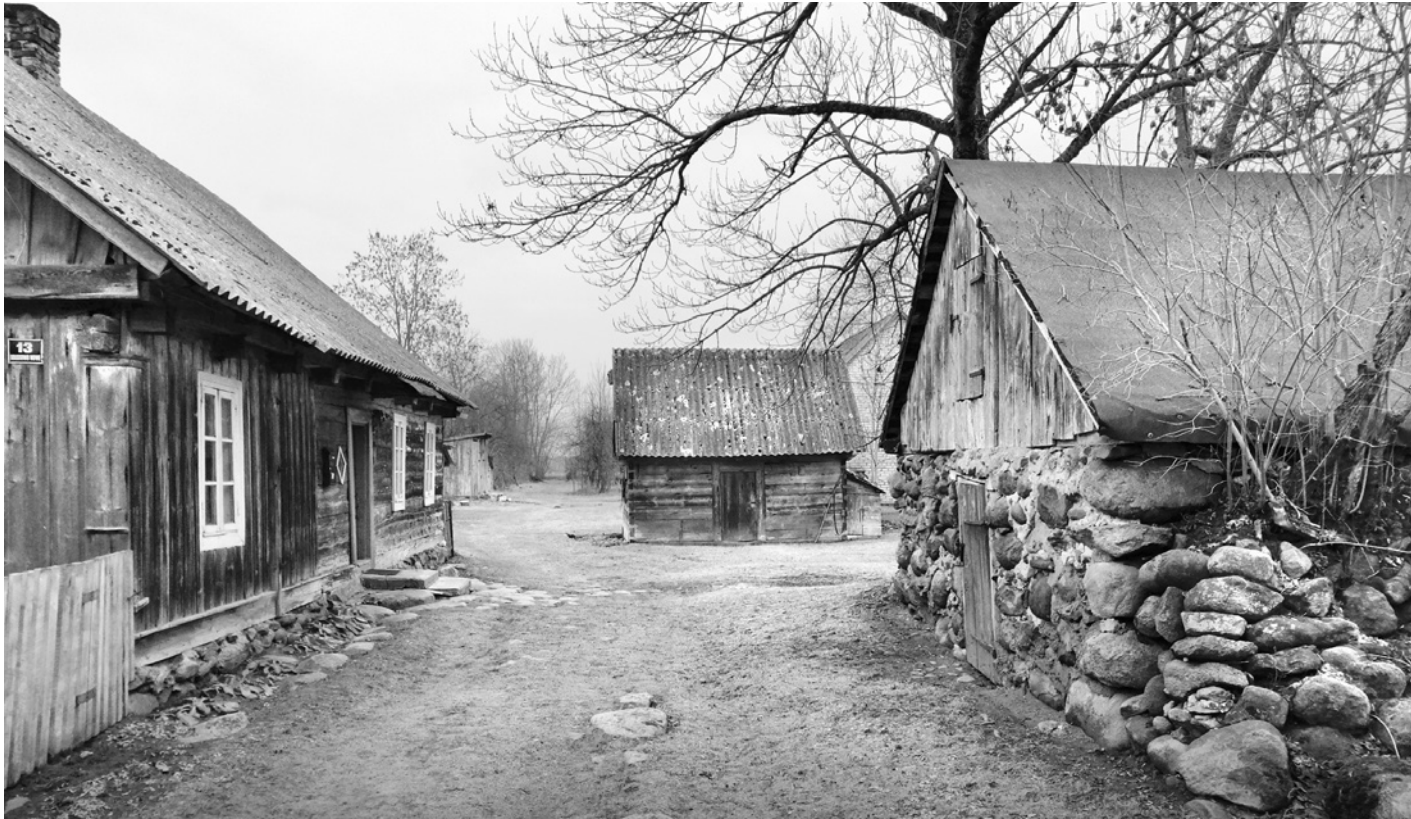
Ryc. 4. Podwórze w Dolistowie Nowym z zachowaną oryginalną zabudową sprzed 80 lat, w tym z przyulicznie sytuowaną piwnicą; fot. J. Świerzińska.
