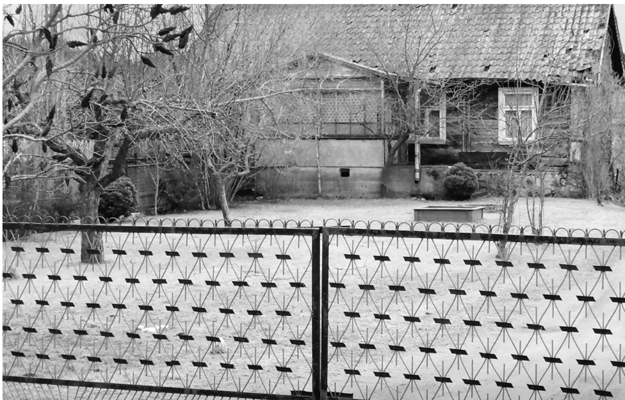
Ryc. 20. Płot ze stali zbrojeniowej; fot. J. Świerzińska.
