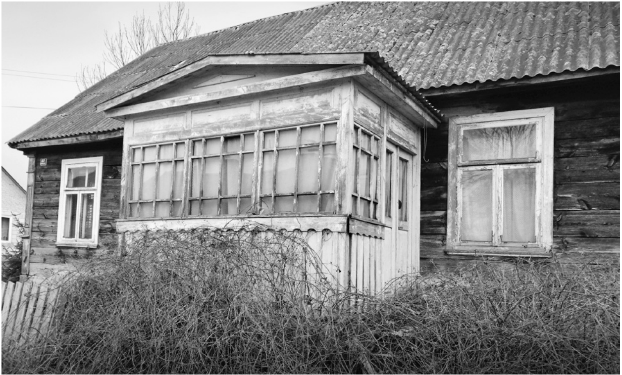
Ryc. 31-34. Stare ganki i werandy; fot. J. Świerzińska. Fig. 31-34. Old porches; source: J. Świerzińska.
