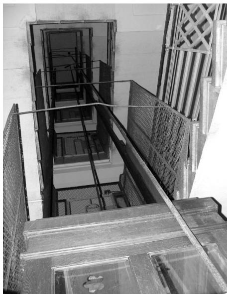
Fot. 5. Dźwig umieszczony między biegiem schodów
