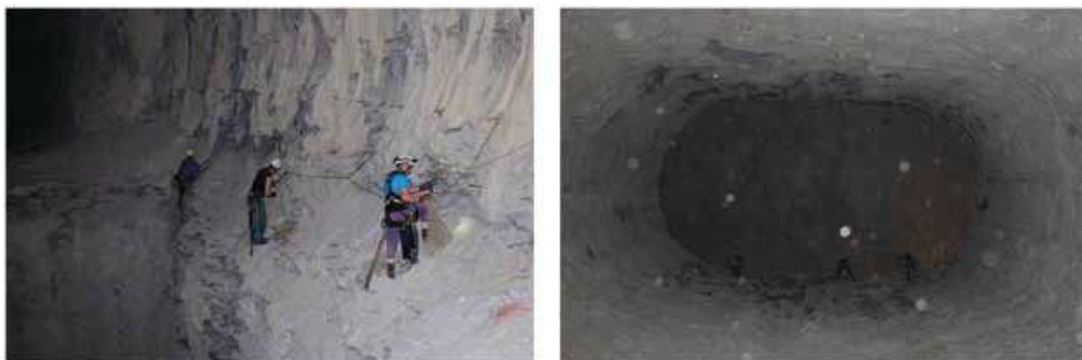
Rys. 2. Ratownicy podczas zabezpieczania zbiornika Z-19 (fot. P. Panajew)
