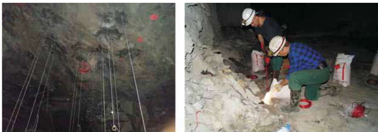
Rys. 1. Oznakowanie odwierconych otworów strzałowych (z lewej) oraz zasypywanie otworów strzałowych saletrolem (z prawej) w zbiorniku retencyjnym urobku Z-19 (fot. M. Rzepa)
