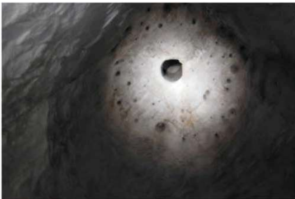
Rys. 6. Zbiornik retencyjny U-22S/1: wygląd po odstrzale I etapu Fig. 6. Retention fore-shaft in salt deposit after first-phase blasting
