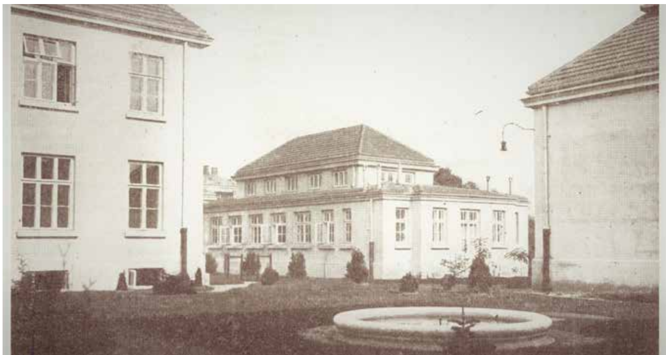
Il. 12. Czesław Domaniewski, Józef Brudziński, szpital Karola i Marii, Warszawa (1913), stacja izolacyjna – widok górnych okienek wentylujących boksy, fot. ok. 1930; źródło [4]
