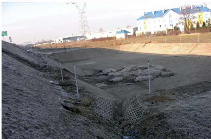
Fot. 1. Przykład osuwiska powstałego wskutek erozji żłobinowej
