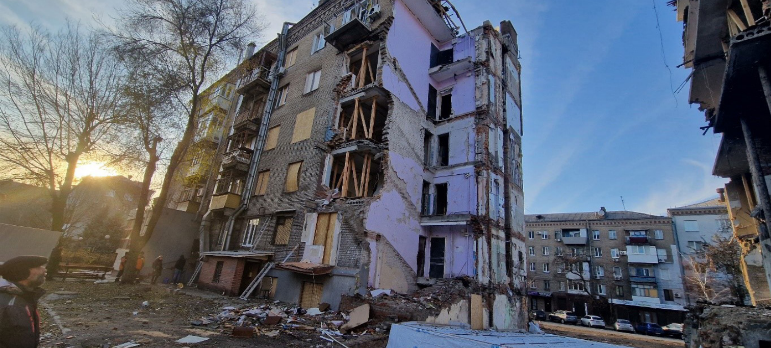
Il. 3. Murowany budynek mieszkalny z płytami prefabrykowanymi trafionymi rakieta, ul. Nowickiego, Zaporozże, 23.11.2022, fot. Nastroy LLC Ill. 3. Residential brick wall building with prefabricated slabs hit by the rocket, Novytskoho Street, Zaporizhzhia, 23.11.2022, photo: Nastroy LLC
