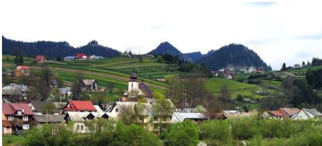
Il. 12. Nowa zabudowa w Sromowcach nad Dunajcem, lokalizowana coraz wyżej i bliżej Pienińskiego Parku Narodowego. Fot. autor
