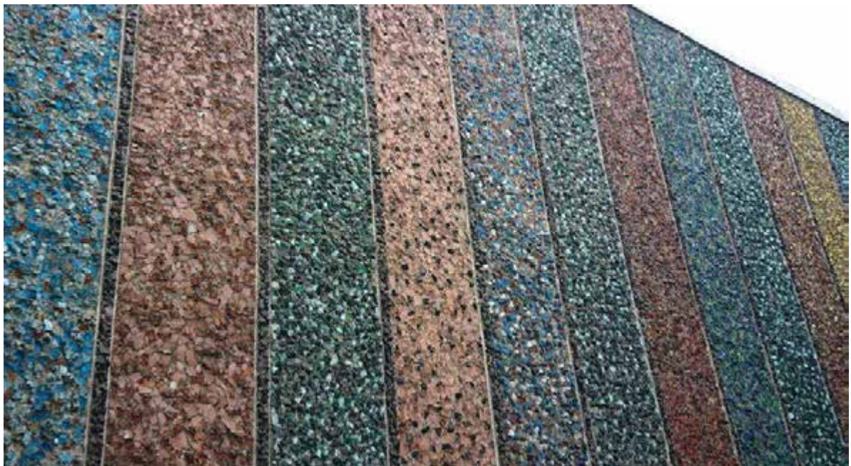
Il. 9. Detal szklanej mozaiki z elewacji Pawilonów wystawowych „Cepelia” w Częstochowie autorstwa Włodzimierza Ściegiennego, stan obecny (zdjęcie: archiwum własne, fot. E. Malec-Zięba).
