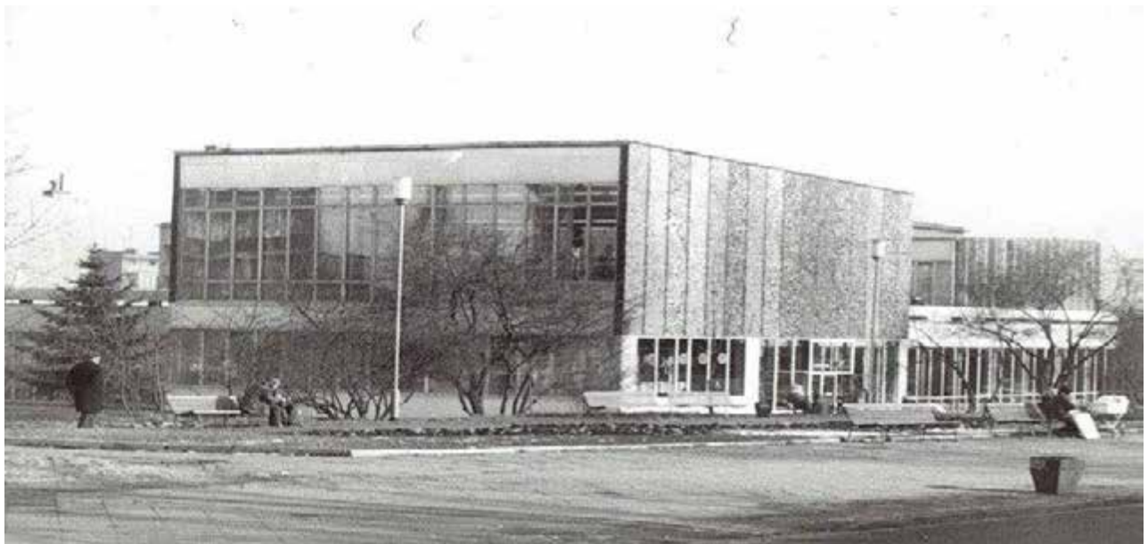
II. 11. Pawilony wystawowe „Cepelia” w Częstochowie autorstwa Włodzimierza Ściegiennego, 1974 rok (zdjęcie: archiwum Ściegiennego).
