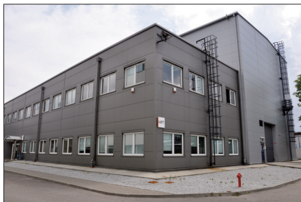
Fot. 16. Budynek hali testów
