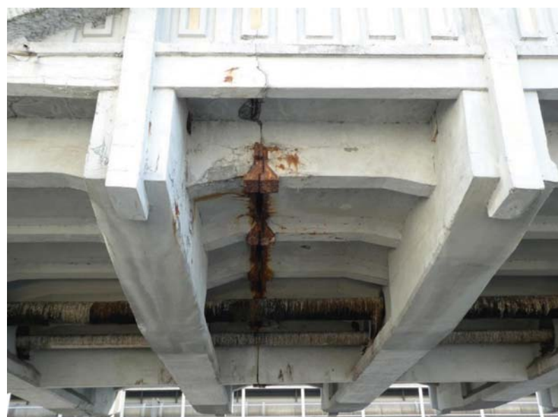
Fot. 16. Stalowe przeguby w linii zdylatowania pomostu od spodu przęsła łukowego nad kanałem żeglugowym
