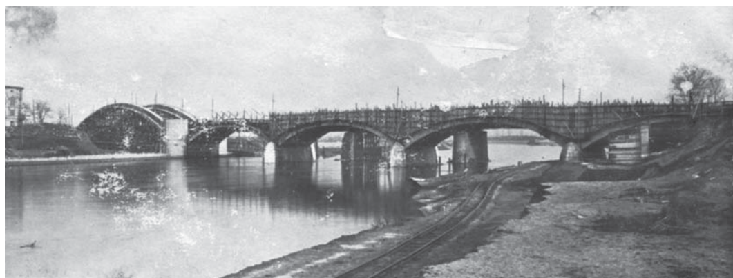
Fot. 11. Przebieg prac przy moście widziany z lewego brzegu Odry od strony WD [1]
