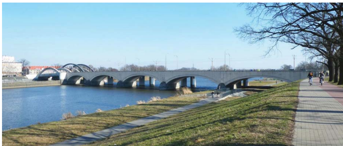
Fot. 15. Widok na mosty Warszawskie z lewego brzegu Starej Odry; na pierwszym planie dawny Hindenburg Brücke
