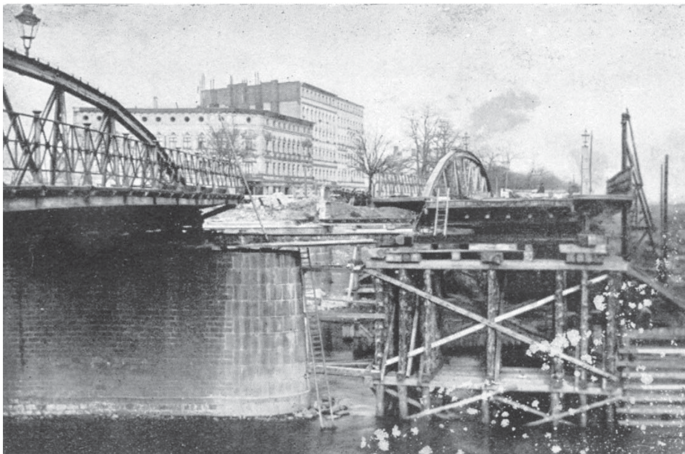
Fot. 2. Budowa mostu tymczasowego z wykorzystaniem starych przęseł [1]
