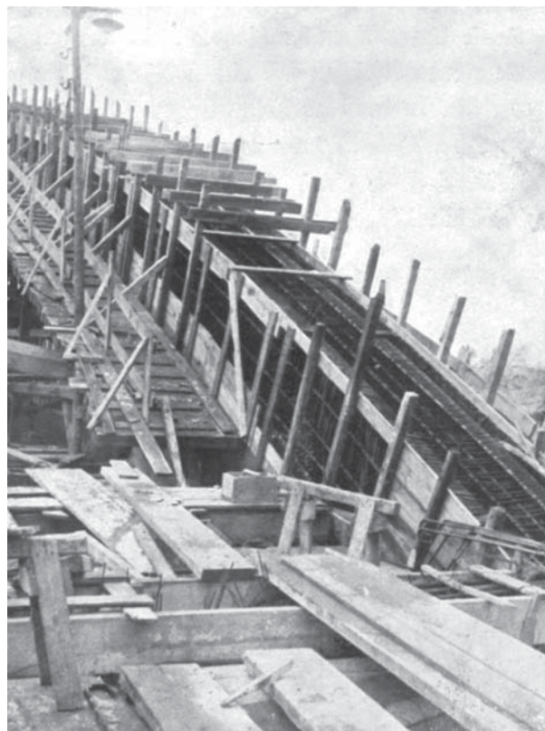
Fot. 8. Montaż deskowania i zbrojenie łukowego dźwigara głównego najdłuższego przęsła [1]
