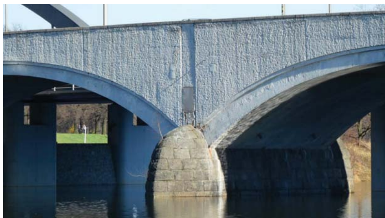
Fot. 17. Filar V od strony wody dolnej i metalowe drzwi w ścianie czołowej, stanowiące wejście do wnętrza podpory
