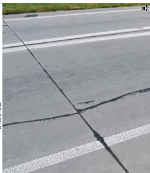
Rys. 3. Widok nawierzchni na dwóch odcinkach badawczych: a) w otoczeniu przekroju B1, b) w otoczeniu przekroju B2 (fot. M. Motylewicz)
