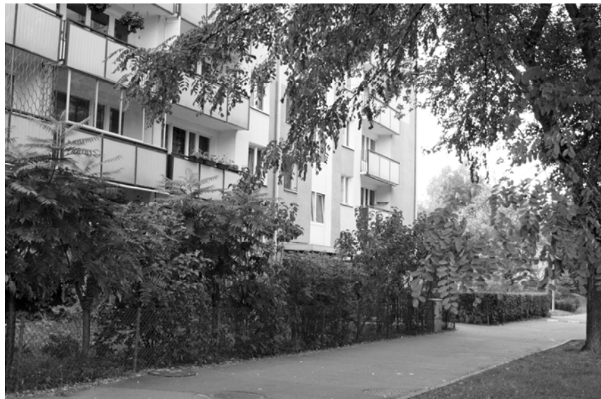
Ryc. 5a. Osiedle Chomiczówka VI w Warszawie Koniec XX wieku. 5b Schemat struktury przestrzeni zamieszkiwanej (linia ciągła oznacza przedogródki, przerywana – przestrzeń społeczną. Źródło: B.J. Gawryszewska.
