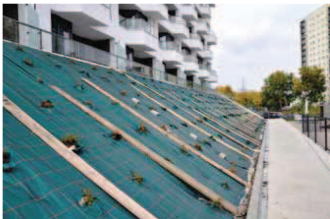
Rys. 5. Zastosowanie GSW na geomembranie z szyskanami, Kraków (fot. Jakub Misiewicz)
