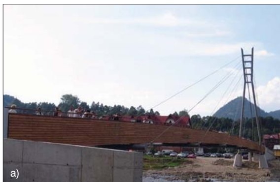
Fot. 2. Kładka nad Dunajcem w Sromowcach Niżnych: a) widok z boku, b) segment przęsła przed montażem (fot. M. Arendarczyk)
