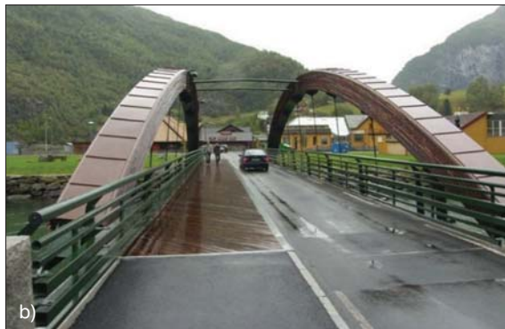
Fot. 5. Most łukowy w miejscowości Flåm, w Norwegii: a) widok z boku, b) widok dojazdu do mostu (fot. D. Rewers)
