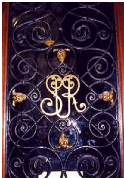
Il. 10. Krata w skrzydle drzwi wejściowych na główną klatkę schodową z monogramem SUR (Stanisław Ursyn Rusiecki); źródło: fot. J. Roguska, 2000
