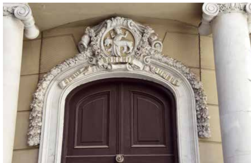
Il. 9. Fragment wejścia głównego do pałacyku przy ul. Lwowskiej 13 w Warszawie. Nad wejściem herb Panna na niedźwiedziu/Rawicz i napis GENUS A BOHEMIE DUCIBUS (Ród z książąt czeskich); źródło: fot. J. Roguska, 2022
