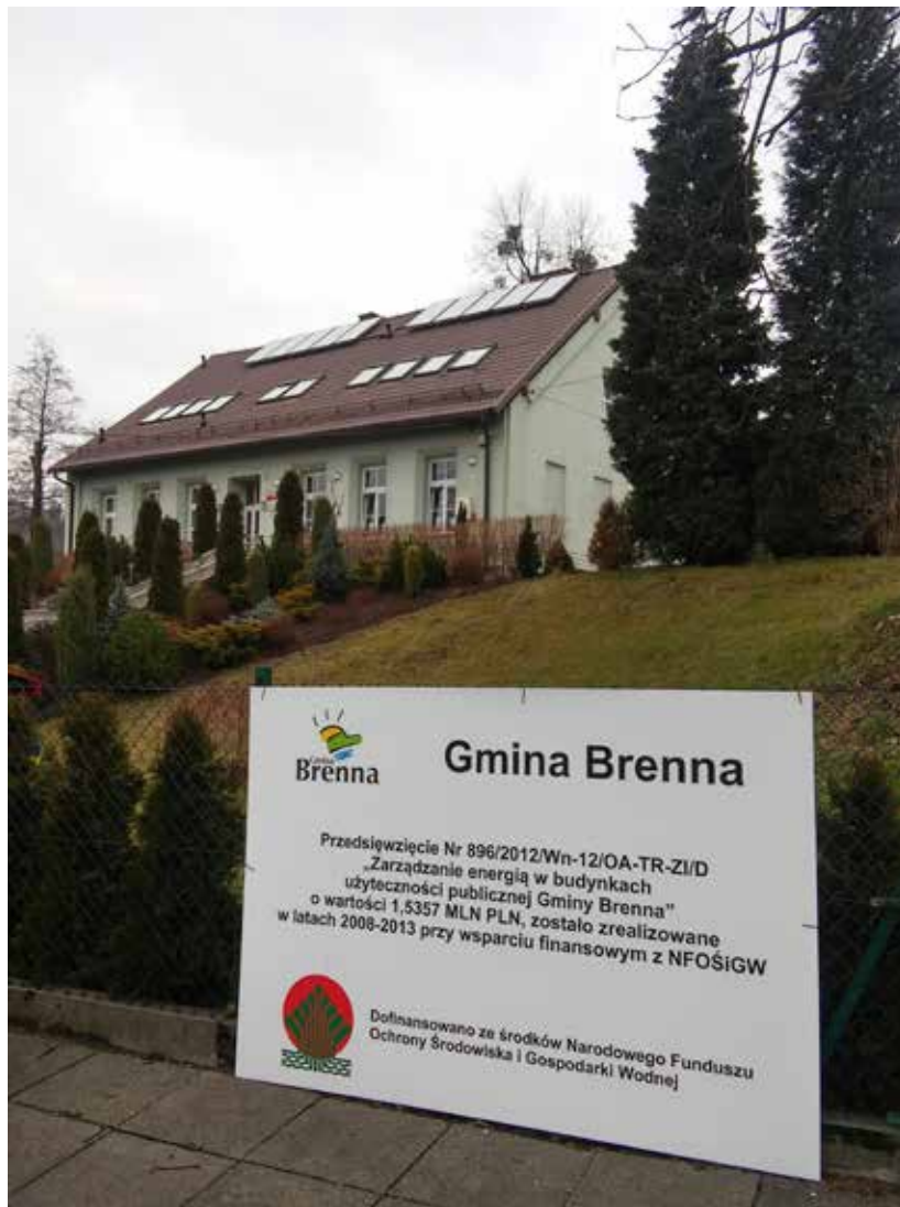
Fot. 2. Przedszkole w gminie Brenna w woj. śląskim po wykonaniu prac termomodernizacyjnych (wraz z kolektorami słonecznymi) - zgodnie z opisem na fotografii. Fot. Urząd Gminy Brenna
