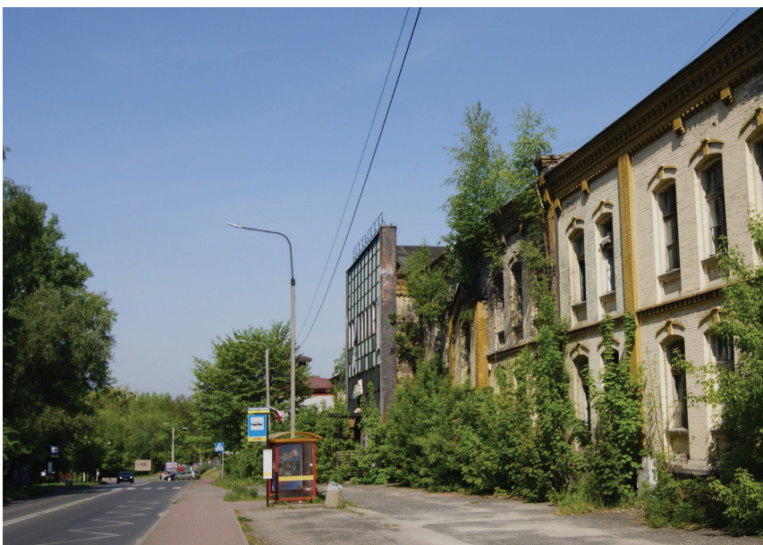
Fot. 4. i 5. Zdjęcia frontu budynków kopalni „Grodziec” od strony ulicy Norberta Barlickiego; źródło: własne, wykonane dnia 4.05.2024
