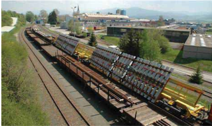
Fot. 7. Transport zmontowanych rozjazdów
