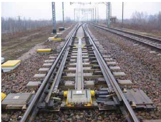
Fot. 5. Hydrauliczny układ przeniesienia siły
