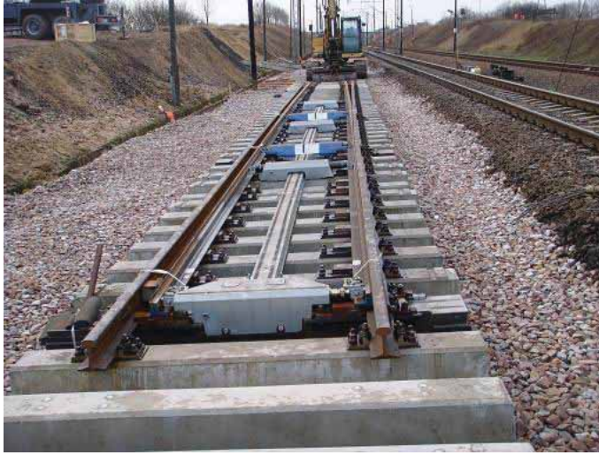
Fot. 6. Rozjazd zmontowany w fabryce dostarczony na plac budowy
