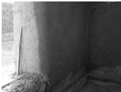
Rys. 3. Częściowo nałożony tynk gliniany [14]. Fig. 3. Partially placed clay plaster [14].
