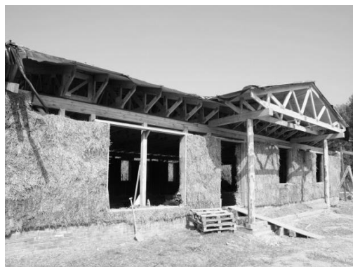
Rys. 2. Szkielet drewniany wypełniony kostkami słomy [14]. Fig. 2. Timber frame filled with straw bales [14].
