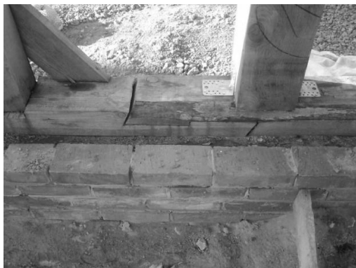
Rys. 4. Konstrukcja ściany cokołowej [14]. Fig. 4. Plinth wall construction [14].
