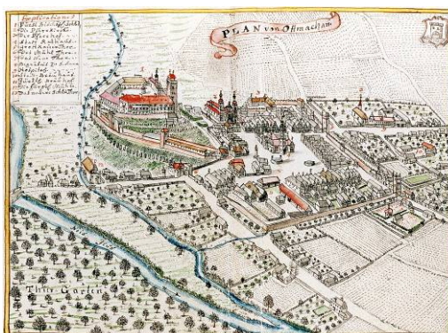
Ryc. 3. Otmuchów. Plan widokowy miasta F.B. Wenera z drugiej połowy XVIII w. Źródło: Biblioteka Uniwersytecka we Wrocławiu
