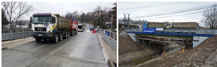
Rys. 7. Próbné obciążenie mostu i stanowisko pomiaru przemieszczeń
